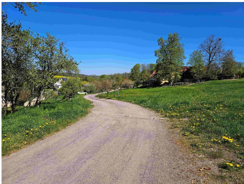
vorhandene Zufahrtstraße Flurstück 22/3
